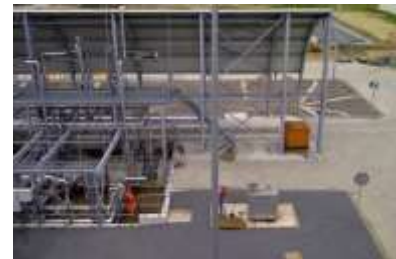
Tankauto laad- en losinstallatie met randapparatuur
